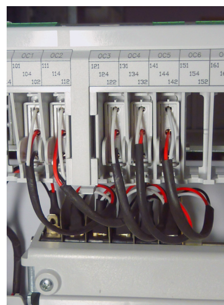
Quatre contacts auxiliaires pré-installés et un contact auxiliaire optionnel
