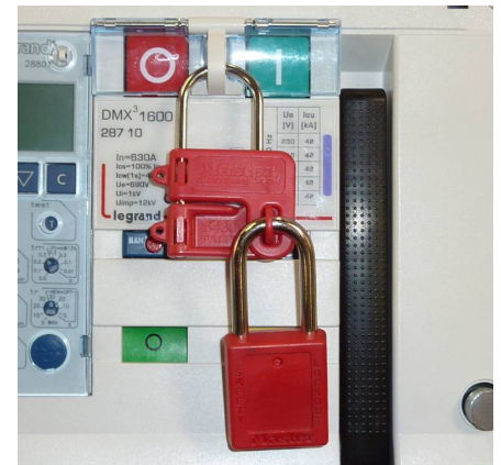
Cadenassage des boutons ON et OFF
