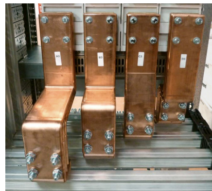
Kit liaison entre DMX 3 taille 1 fixe et jeu de barre de transfert en aluminium
